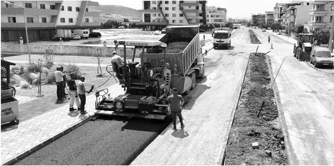
MANİSA'NIN Akhisar ilçesinde, belediye tarafından başlatılan asfalt çalışmaları tüm hızıyla devam ediyor.
